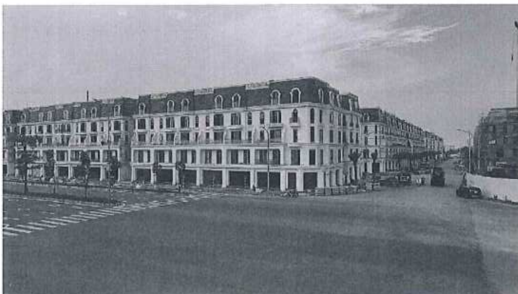
Một góc dự án đã hoàn thiện tại thời điểm tháng 07/2026
