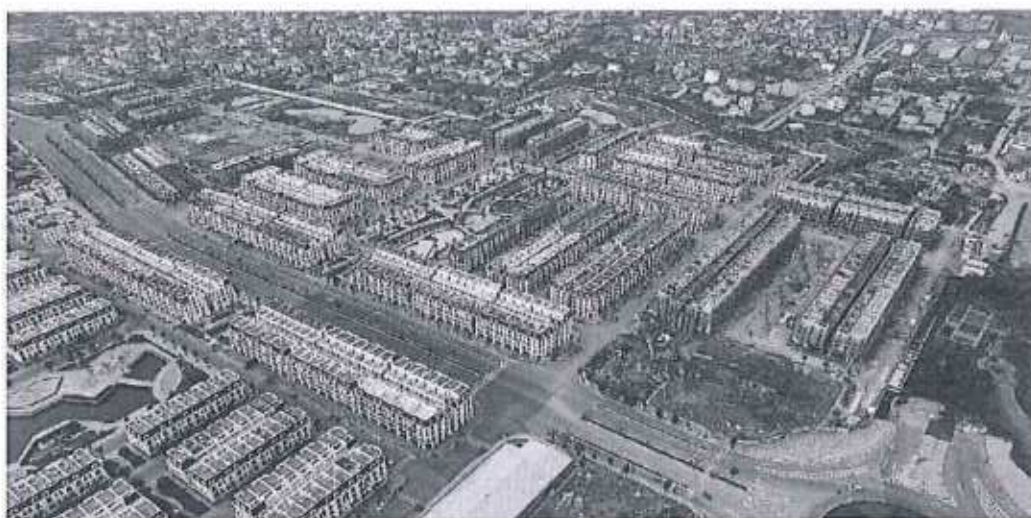
Toàn cảnh dự án đang triển khai thi công đang hoàn thiện một số phân khu
